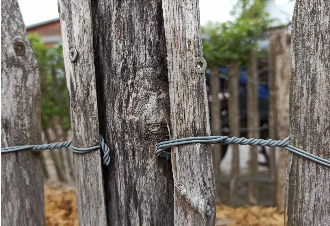
Abbildung 18 Die Staketen von Anfang und Ende des Zauns werden an einem Pfosten verschraubt.
