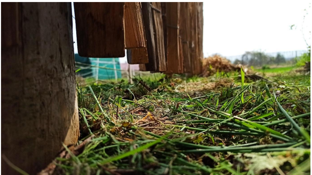
Abbildung 13 Durch den Abstand des Staketenzauns zum Boden verlängert sich die Haltbarkeit des Kastanienholz.
