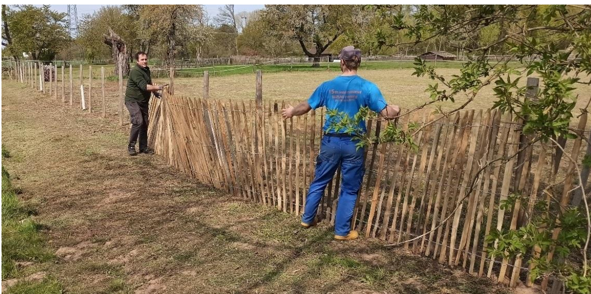
Abbildung 9 Staketenzaun aufstellen.
