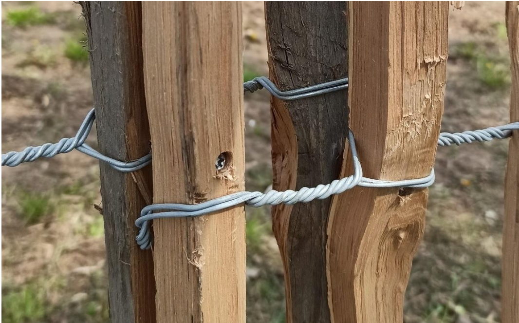
Abbildung 16 Die Staketen von Anfang und Ende des Staketenzauns werden aufeinander geschraubt.
