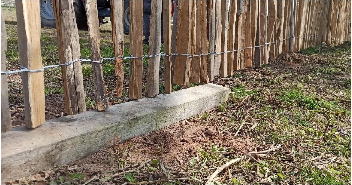
Abbildung 12 Holzbalken als Abstandshalter zur Montage unter den Staketenzaun legen.
