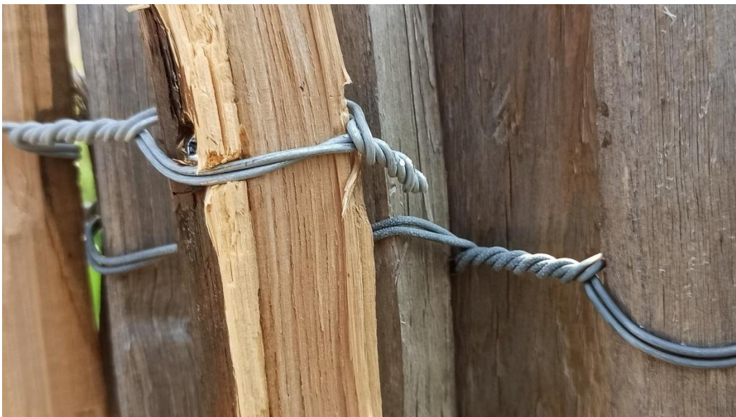
Abbildung 15 Drahtende nach hinten umschlagen.
