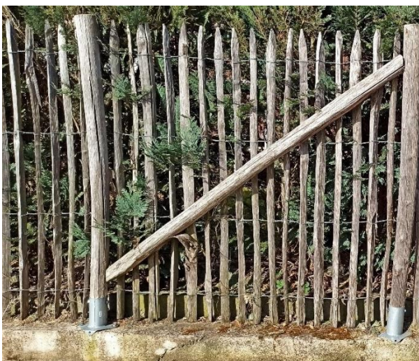
Abbildung 5 45°-Stütze aus Rundhölzer.
