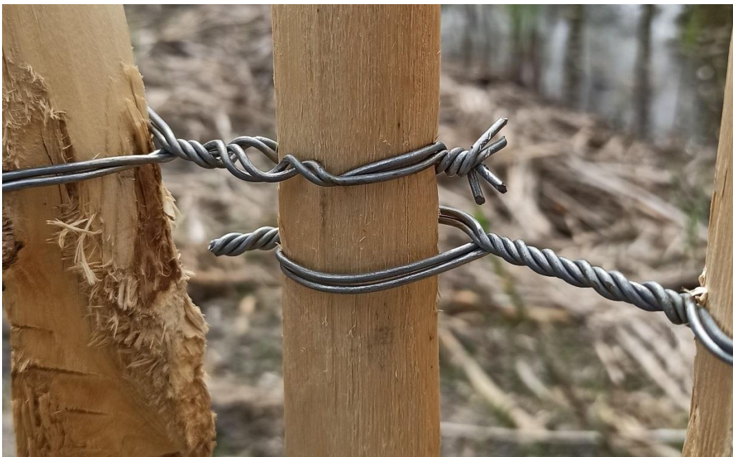
Abbildung 17 Draht aufdrehen um Anfang und Ende des Staketenzauns miteinander zu verbinden.
