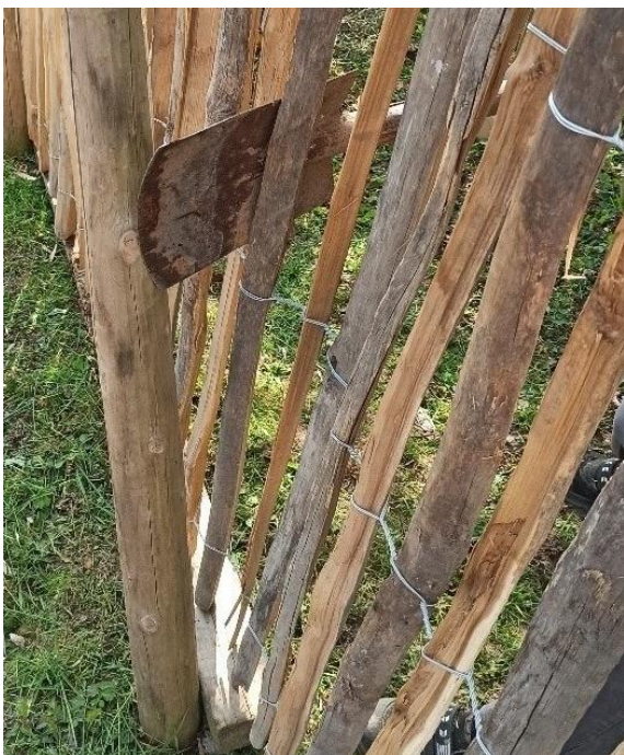
Abbildung 11 Staketenzaun mit Spaten spannen.
