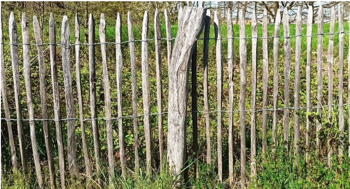
Abbildung 6 Beispiel von einem krummen Pfosten (Seitenansicht).
