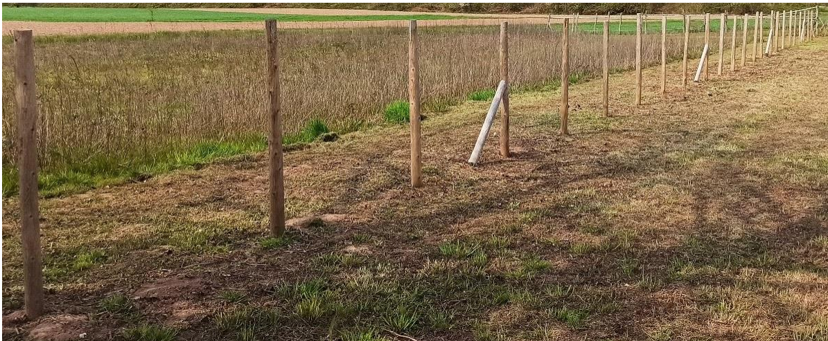
Abbildung 2 Pfähle mit 45°-Stützen.
