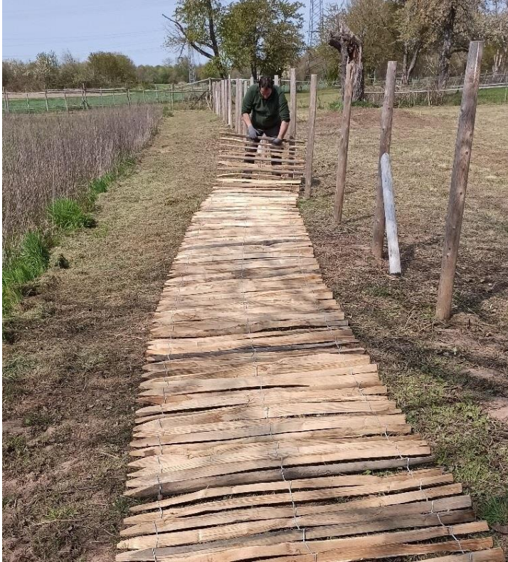
Abbildung 8 Staketenzaun ausrollen und vorspannen.
