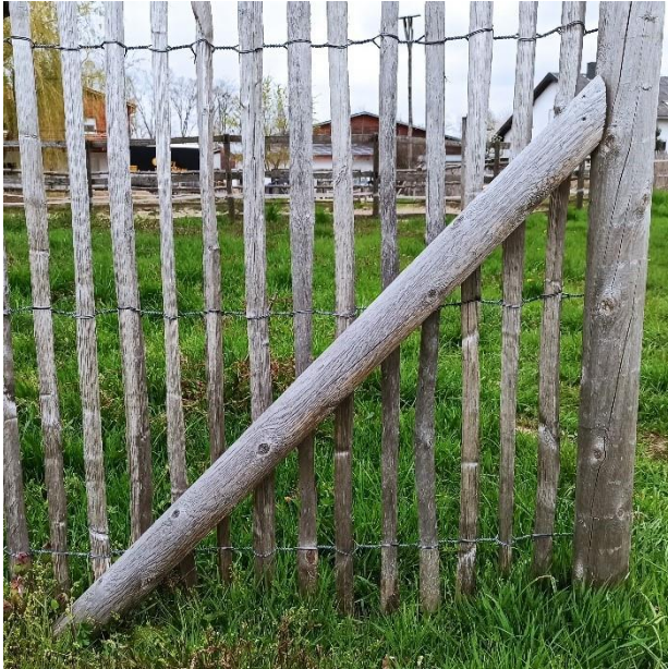
Abbildung 1 45°-Stütze aus Pfählen.
