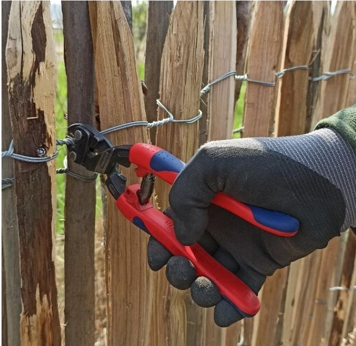
Abbildung 14 Beispiel Kastanienzaun zuschneiden mit Bolzenschneider.
